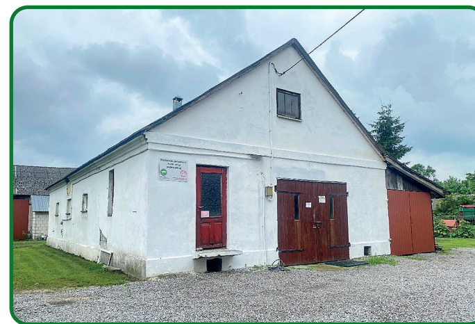
Fot. 17. Chlewnia Roberta Zabielskiego – Lichty (fot. Jerzy Bajda)
